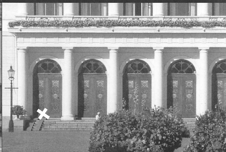
Rampen på trappan till detta nyklassiska byggnadsverk är snarare en del av problemet än av lösningen. Olycksrisken är stor även med barnvagn.
