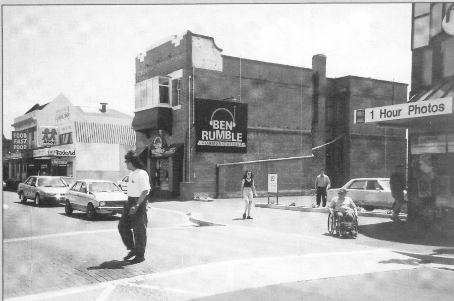
Upphöjda övergångsställen i Gisborn i New Zealand
